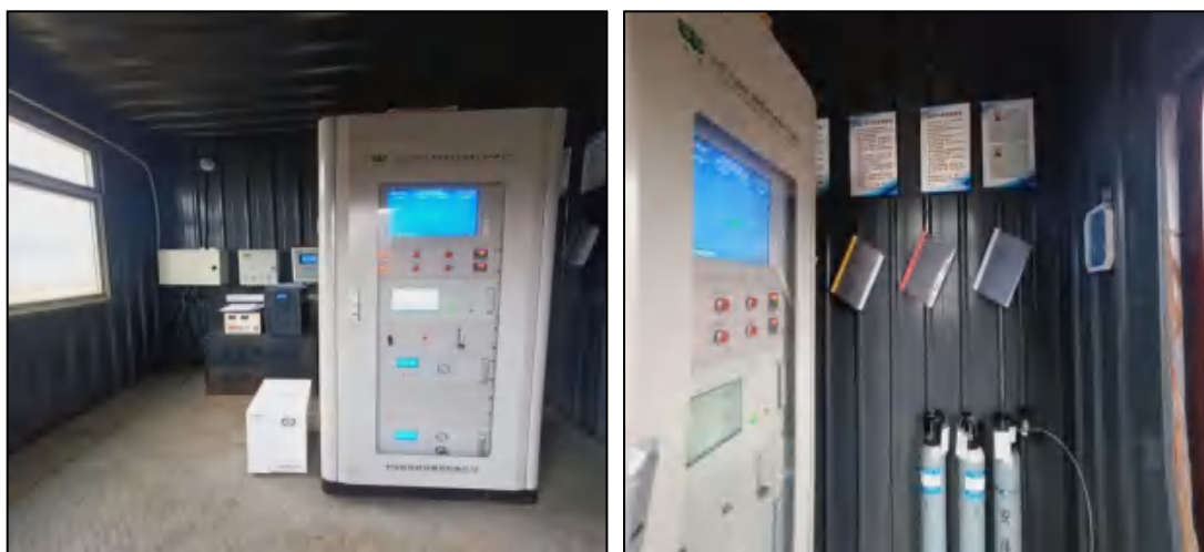
图 4.2-3 废气在线监测设备房
