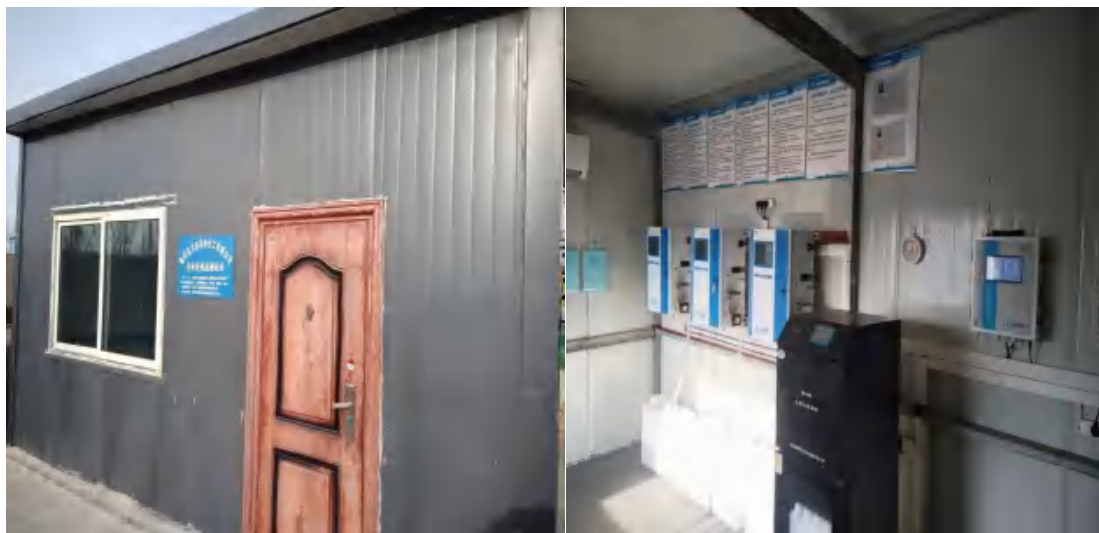
图 4.2-4 废水在线监测设备房
