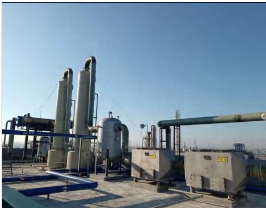
工艺有机废气治理设施（二级深冷+一级水吸收+一级碱吸收+一级活性炭）
