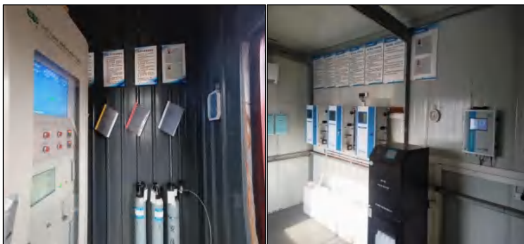
图 4.2-5 废水在线监测设备
