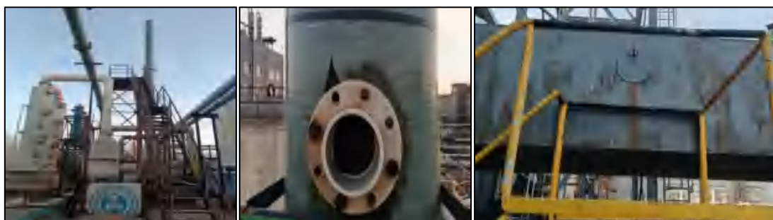
图 4.2-2 废气监测孔及采样平台
