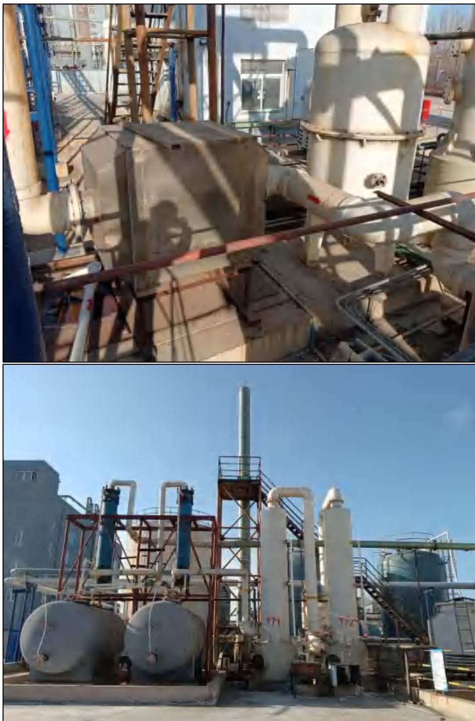
危废贮存库废气治理设施（二级冷凝+二级碱洗+一级活性炭）及 DA012 排放口
